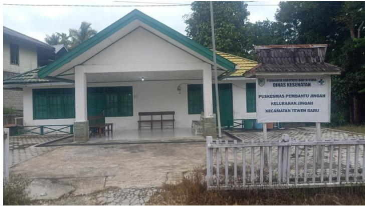
Gambar 1. Puskesmas Pembantu Jingah Kecamatan Teweh Baru
